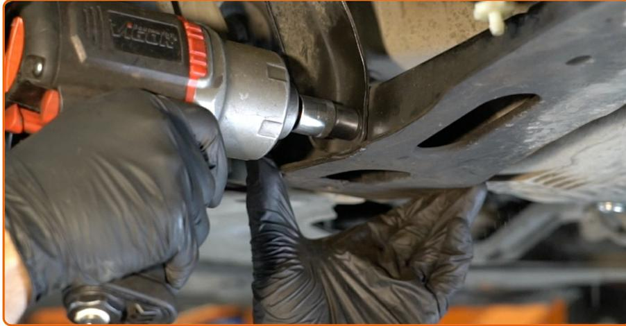
Vissez les fixations des supports de renforcement du sous-châssis. Utilisez une douille n° 13. Utilisez une clé à cliquet.
