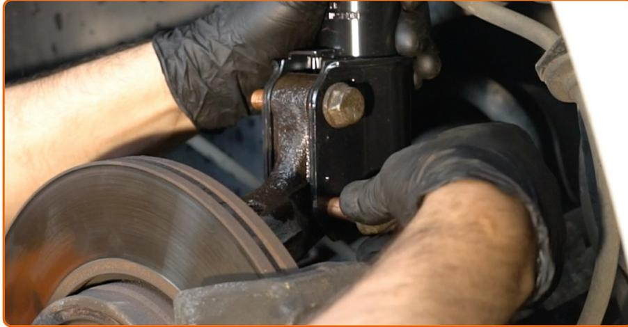
Installez les boulons de fixation.
